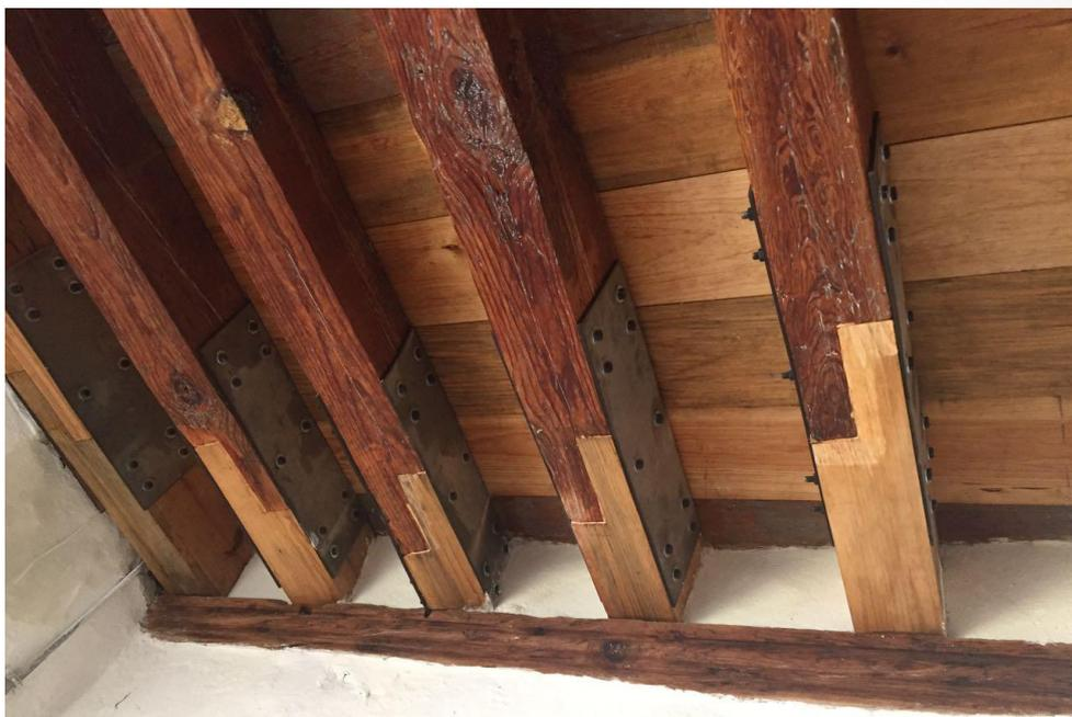
**Fotografía 6. Ejemplo de vigas con las cabezas reforzadas con injertos de madera nueva y placas metálicas atornilladas. Fuente: JLB**
