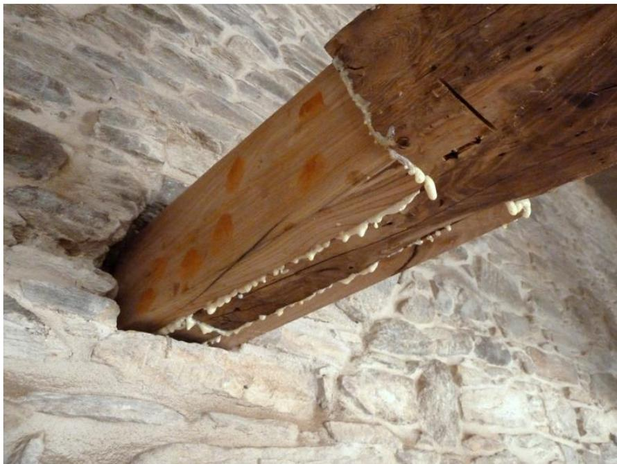
Fotografía 5. Injerto de madera nueva para reforzar la cabeza de una viga de castaño.
