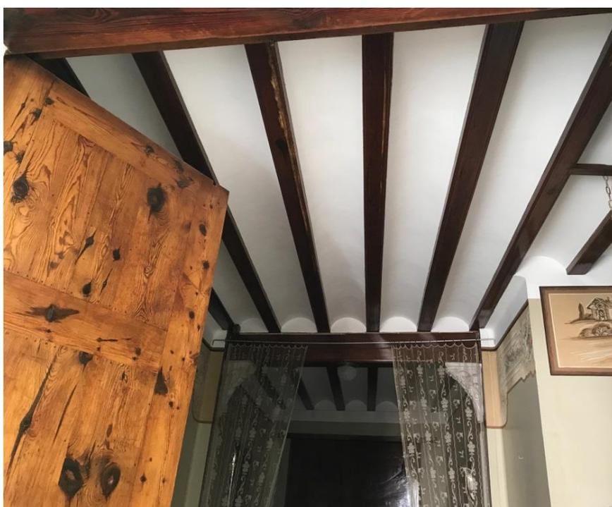
**Fotografía 2. Solución constructiva de forjado típica en las casas de principio de siglo XX en Massanassa (las vigas son de mobila y por ello se han conservado muy bien).**
